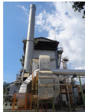
รูปที่ 3-9 อุปกรณ์บำบัดฝุ่น (Electrostatic Precipitator) จาก Boiler Type
