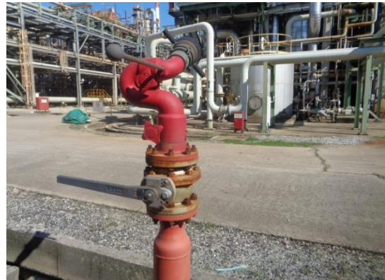
รูปที่ 3-46 Fixed Water Monitor
