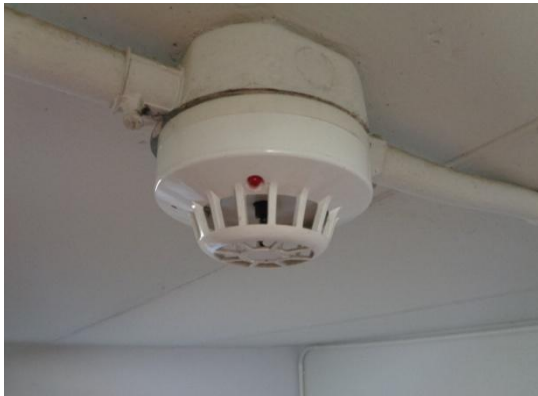
รูปที่ 3-39 Heat Detector
