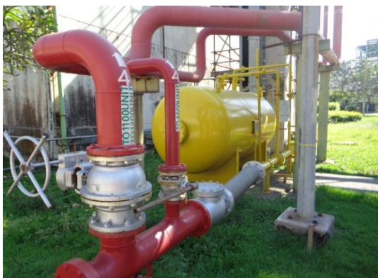
รูปที่ 3-49 Fixed Foam Discharge Outlet
