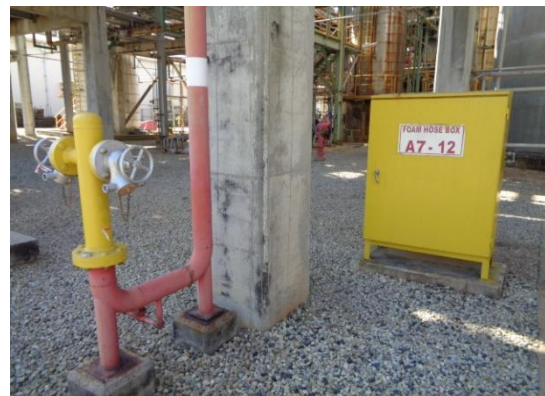
รูปที่ 3-48 Foam Hydrant
