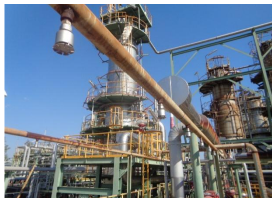
รูปที่ 3-50 Fixed Foam Spray System
